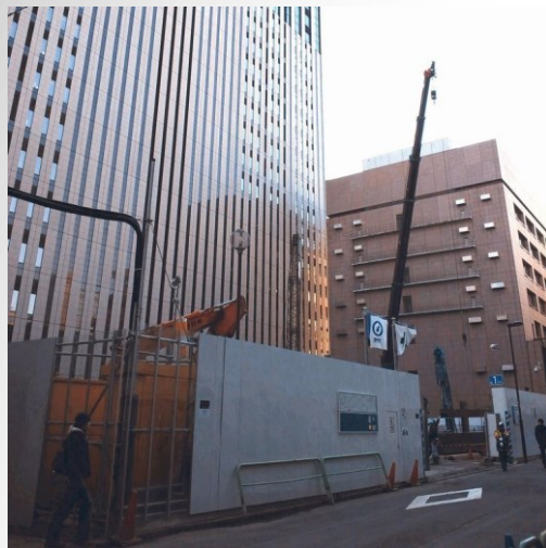
南棟(仮称)建設工事中の6・9号館跡地
